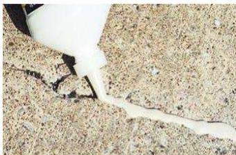
Se puede utilizar cola de rata por debajo del sellador de la grieta para controlar el uso de material.
